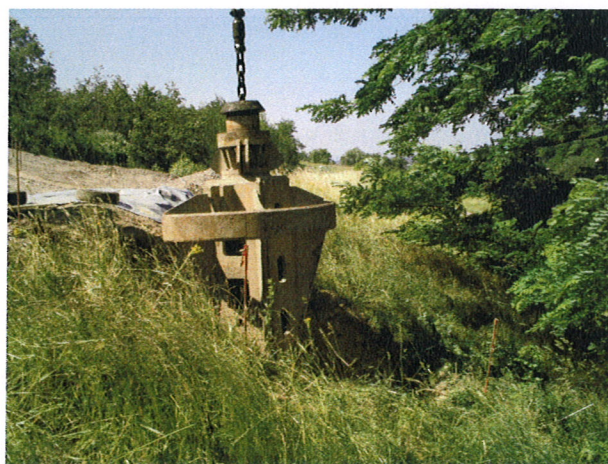
Bild 2: Beginn der Aushubarbeiten für einen Tandemschacht
