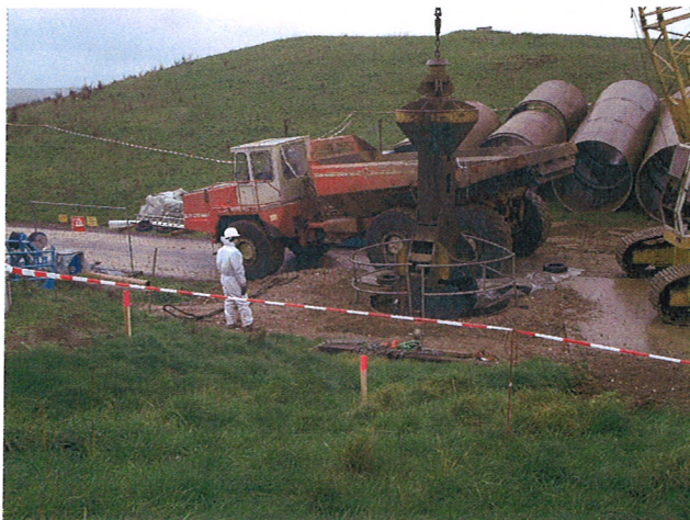
Bild 1: Schachterrichtung mittels Greiferbohrung, Abfallaushub und sofortige Verladung auf Muldenfahrzeug
