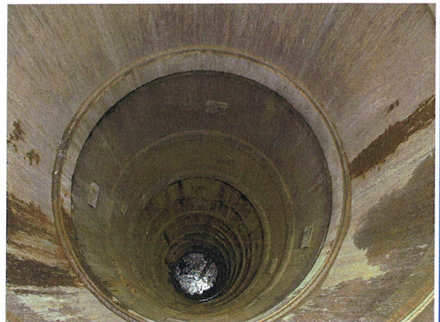
Bild 2: Lotrechter Schacht mit Stahlrohrverbau, hier: Berst-rakete bei Eintritt in den Zielschacht
