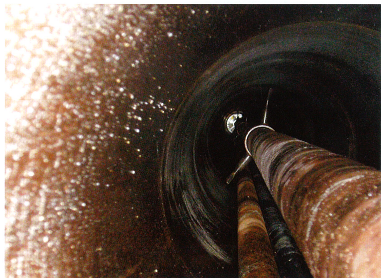
Abb. 10 Blick in das Bohrrohr nach der ersten im WHD-Bohrverfahren hergestellten Strangbohrung.
