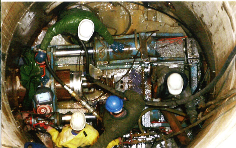
Abb. 11 Brunnenschacht während des ersten Praxiseinsatzes der WHD-Bohrtechnik in Augsburg.
