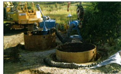
Bild 1: Offener Tandemschacht mit Bewetterung
