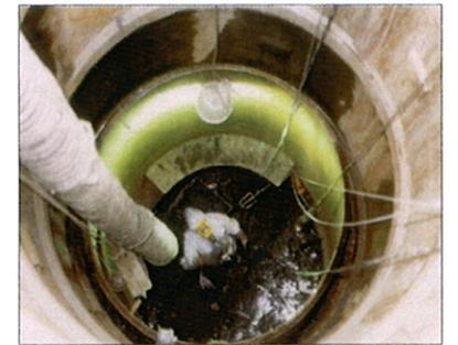
Bild 5: Arbeiten auf der Deponiesohle unter Vollschutz
