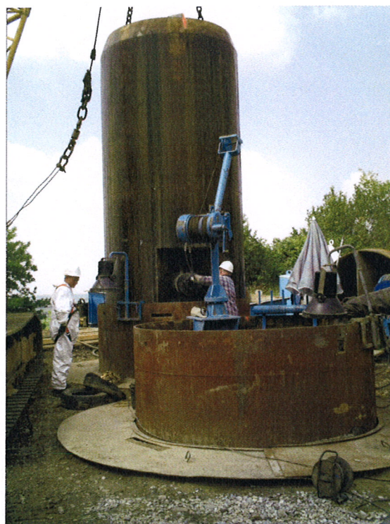
Bild 2: Tunnelpresse beim Ausfahren aus dem Schacht
