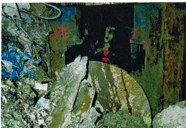
Bild 1: Tunnelpresse bei der Arbeit auf der Deponiesohle
