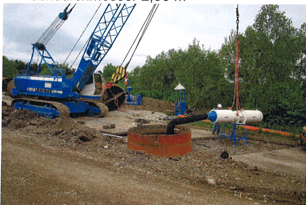
Bild 1: Schachtbewetterung mittels eines Axialventilators (ca. 4 m³/s)
