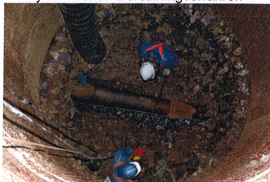
Bild 2: Einführung der Berstrakte in die Steinzeugleitung im Startschacht auf der Deponiebasis
