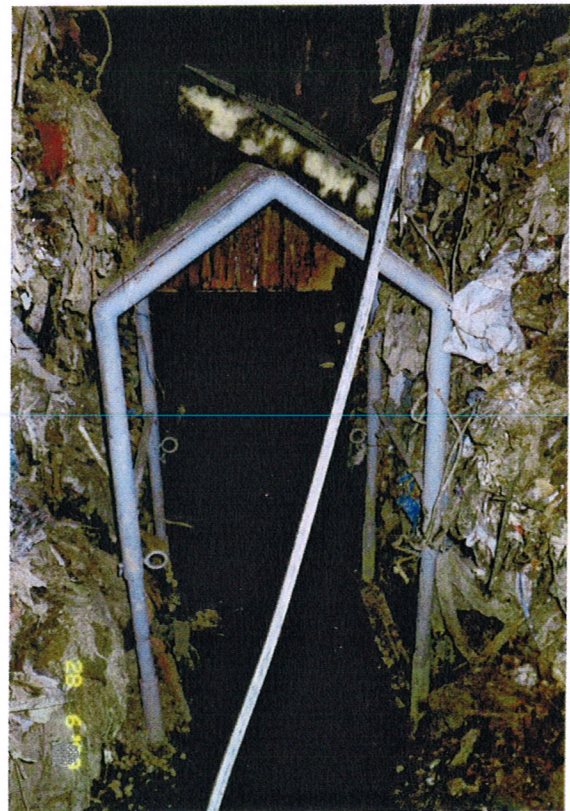
Bild 2: Einstellsicherung innerhalb des Tunnels
