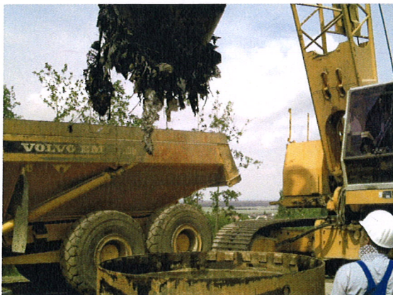
Bild 1: Abfallaushub und Verladung mittels Greifer
